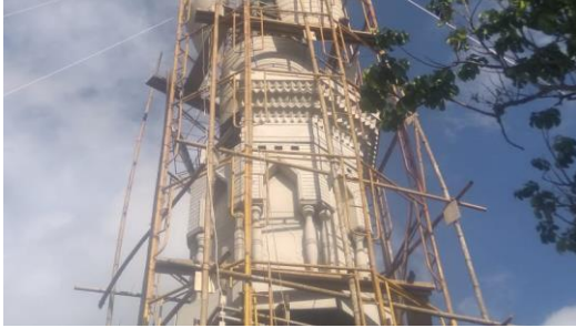
Gambar 3. Panel GRC sesudah dipasang (Sumber: Situasi Proyek di Lapangan)
