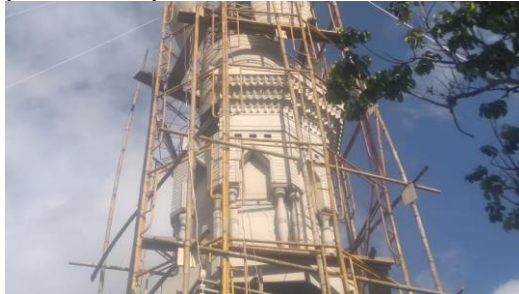
Gambar 3. Panel GRC setelah dipasang (Sumber: Situasi Proyek di Lapangan)
