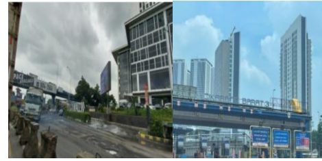
Gambar 4. Kondisi Eksisting Infrastruktur (Sumber : Dokumentasi lapangan peneliti, 2026)
