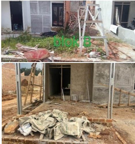
Gambar 3. Limbah kayu bekisting dan sisa karung semen di Perumahan Sidosari (Sumber : Dokumentasi Proyek, 2026)
