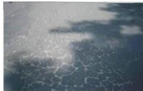
Gambar 9. Pelepasan Butir (Sumber: Data Hasil Survei)
