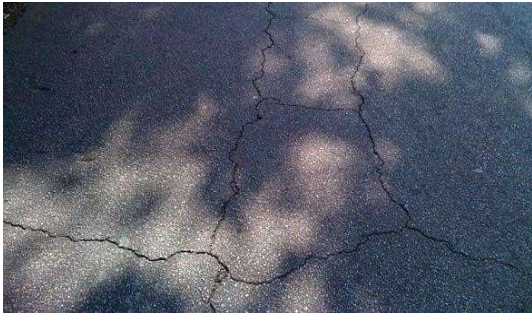
Gambar 4. Retak Blok (Sumber: Gilang Mahendra, 2019)
