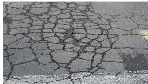
Gambar 3. Retak Kulit Buaya (Sumber: Wikipedia, 2023)
