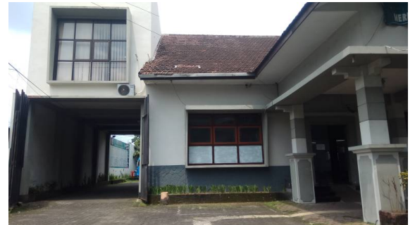
Gambar 2. Kondisi area parkir pemustaka difabel saat peresmian Braille Corner
