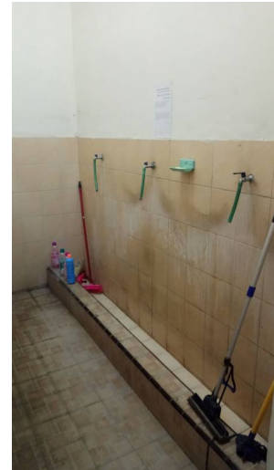
Gambar 7. Kondisi tempat wudhu
