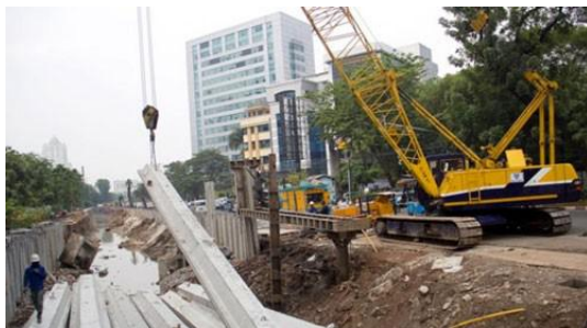
Gambar 3. Pemancangan Sheet Pile
